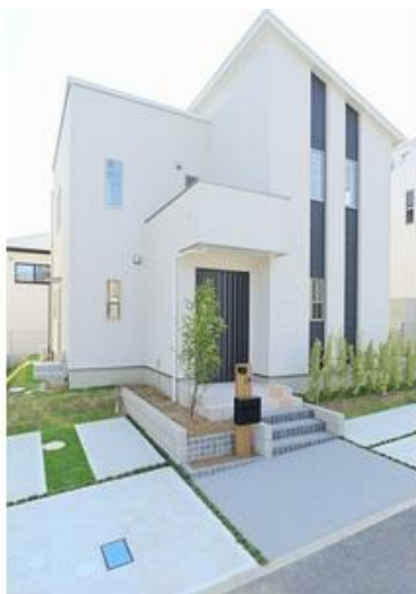
5号棟 外観完成
