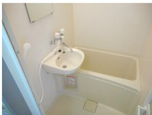
洗面台が設置された機能的なバスルーム♪
