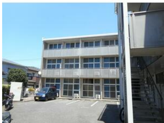
敷地内の駐車場です。駐車しやすい自走平置式♪
