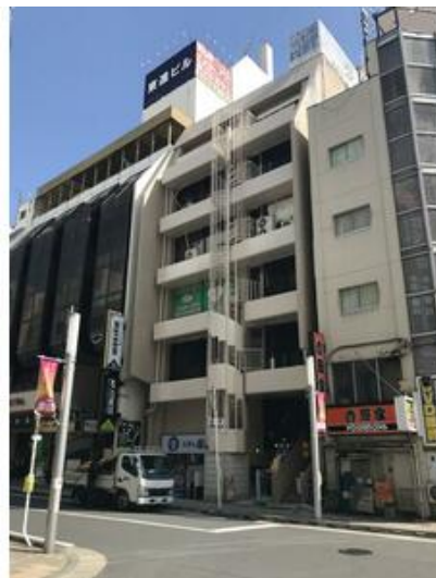
通り沿いの好立地! 外壁塗装しました。
