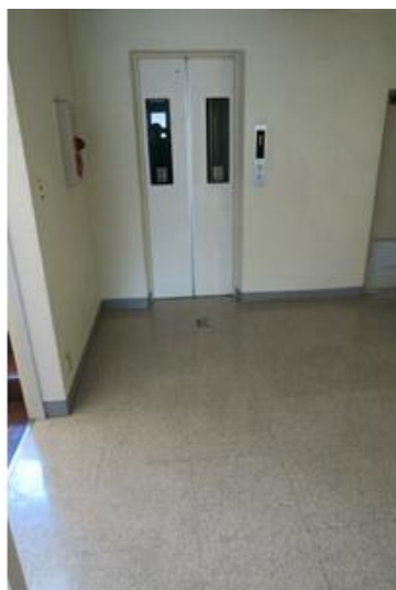
エレベーター前
