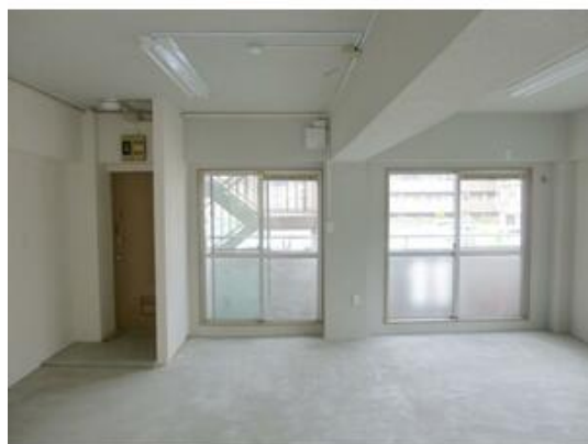
店舗部分(床コンクリート)
