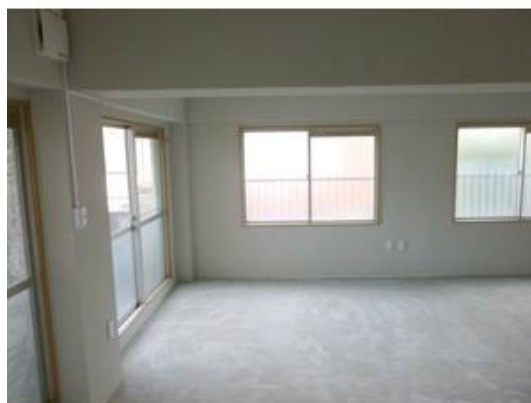
店舗部分(床コンクリート)
