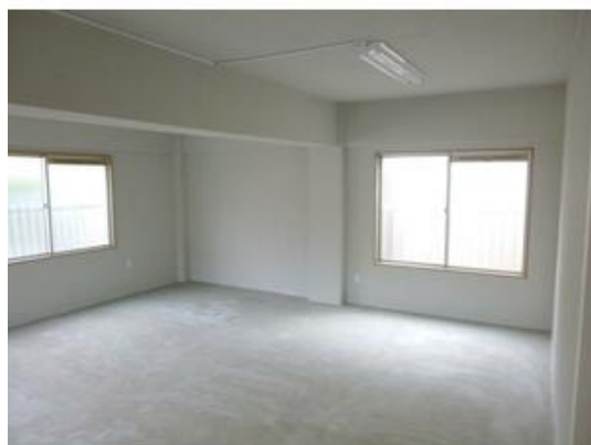
店舗部分(床コンクリート)
