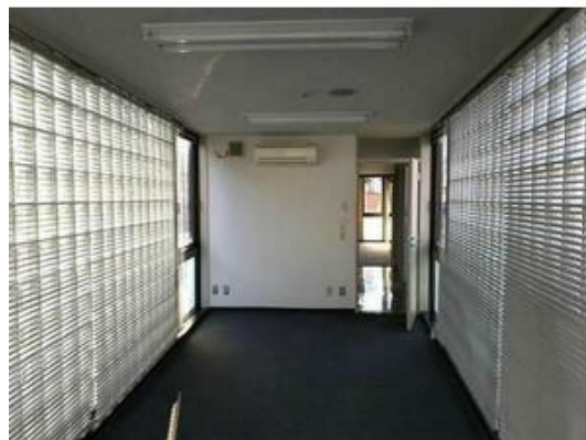
3階東側事務室(西側に向かって撮影)
