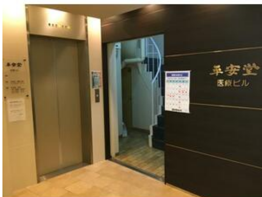
エントランス改修しており、綺麗な印象です
