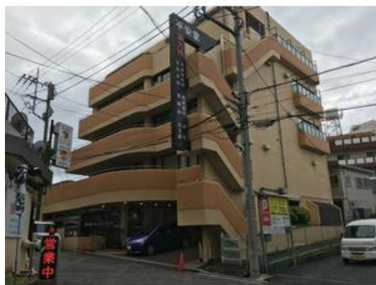
平成23年外装等リフォーム実施済 エントランスも改修されており綺麗な印象です
